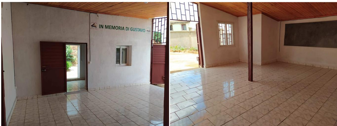
Les travaux de réhabilitation ont eu lieu au début de l'année 2021 et consistaient notamment à la réfection de la toiture, pose de voliges, pose de carrelage, remplacement des portes et fenêtres, peinture intérieure et extérieure.
